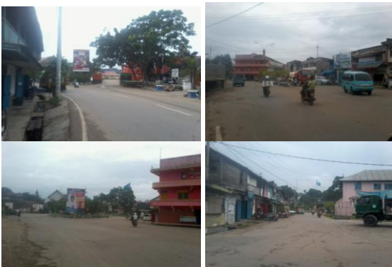
Gambar 7. Foto-foto Jaringan Jalan Sumber : Survey, 2012
